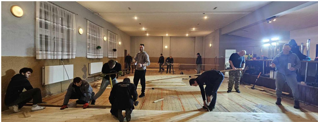
Fot. Druhowie podczas prac przy układaniu nowej podłogi
