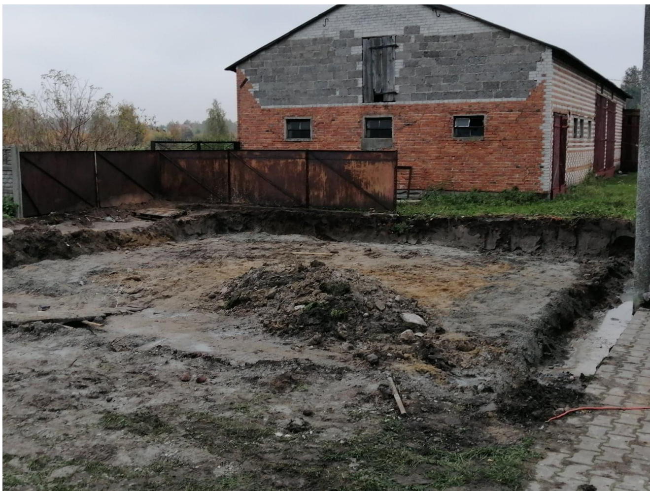
Budowa nowego garażu wraz z zapleczem technicznym
